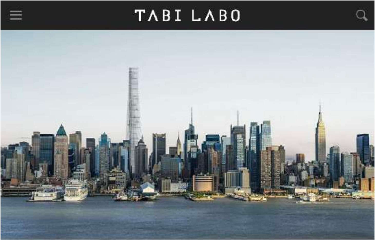
「畑」から「病院」まで併設された、生態系が完結するビル
